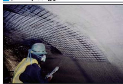
■ トンネル覆工
